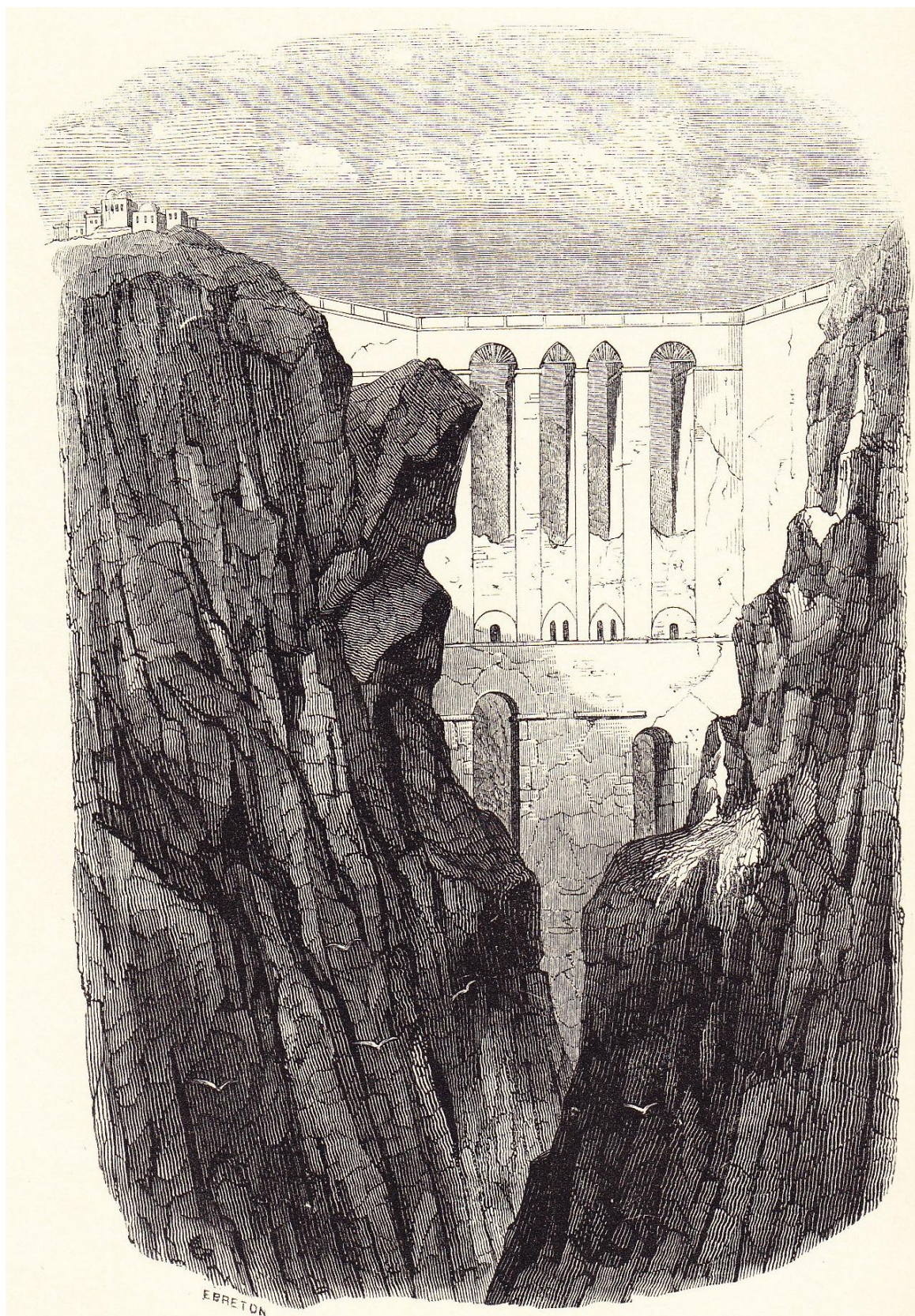
PONT D'ALCANTARA, A CONSTANTINE.
